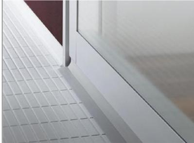
入った空気がドアに沿うように下に流れて、浴室全体を換気します。
